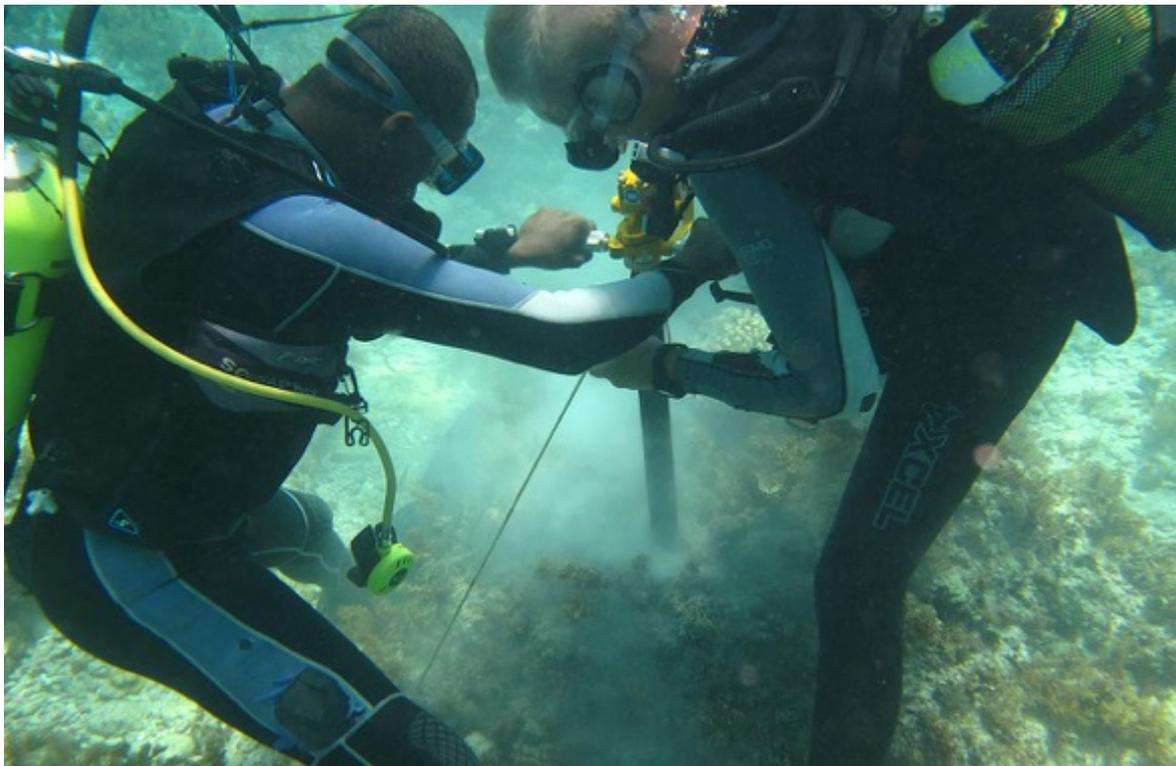
Okala und Chrigel mühen sich mit dem UW-Hydraulikbohrer ab für eine stabile Verankerung der Bojen.
